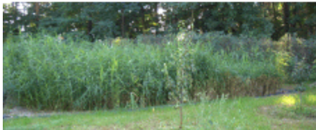
Pflanzenkläranlage im 2. Jahr
